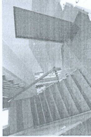
Fot. 5. Widok na wnętrze budynku
